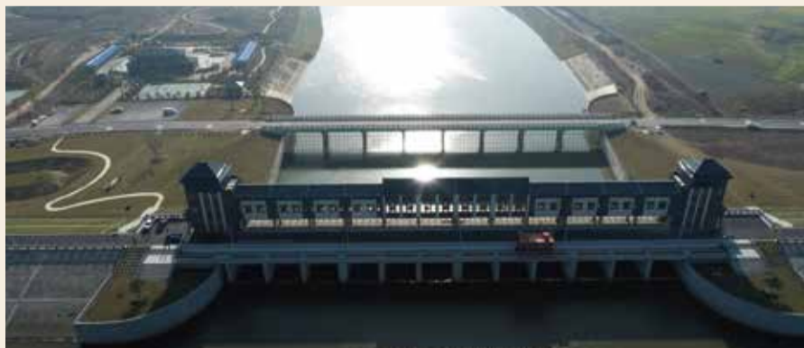
安徽省定远县江巷水库运行管理调度系统
